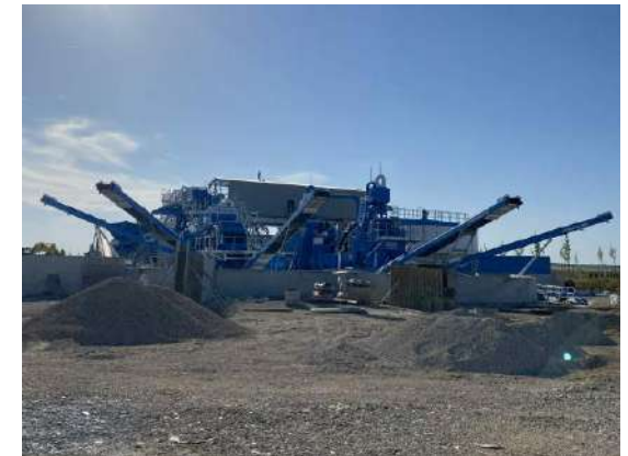
Plateforme de traitement et de recyclage de gravas de démolition (source : https://www.granudem.fr/ )
